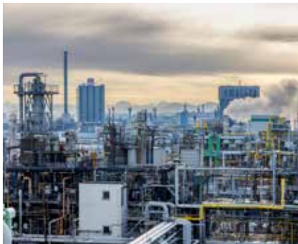
Standort Burghausen: Die Wacker Chemie AG ist ein weltweit führender Spezialchemiekonzern, der sich auf silicon- und ethylenbasierte Produkte sowie Polysilizium konzentriert. Foto: Wacker
