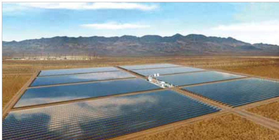
Solar-Receiver des Technologiekonzerns SCHOTT bilden das Herzstück des drittgrößten Solarwärmekraftwerks der Welt „Nevada Solar One“.
