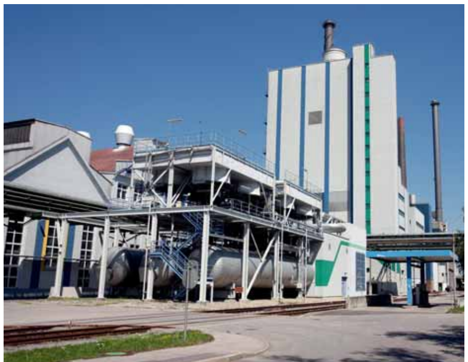
Gas- und Dampfturbinenkraftwerk am Standort Burghausen: Energieeffizienz bei der Herstellung energiesparender Produkte ist für Wacker ein Zukunftsthema. Foto: Wacker Chemie AG
