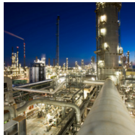
Pyrolyseöle aus thermochemischen Recyclingverfahren sind Naphtha sehr ähnlich und können ganz am Anfang in die Chemieproduktion eingespeist werden, um fossile Rohstoffe zu ersetzen. Im Steamcracker der BASF in Ludwigshafen (rechts) wurde dieses Verfahren bereits erprobt. Fotos: BASF
