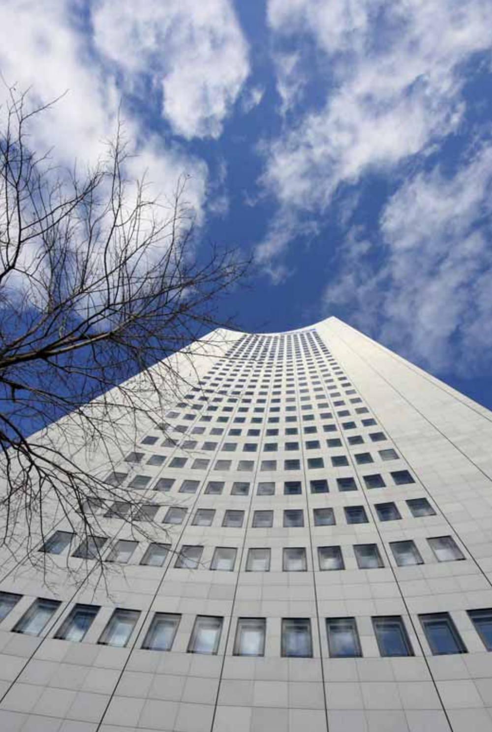
Auf insgesamt vier Etagen des City-Hochhauses am Augustusplatz im Herzen von Leipzig verteilen sich die Räumlichkeiten der EEX. Foto: Ralph Koch
