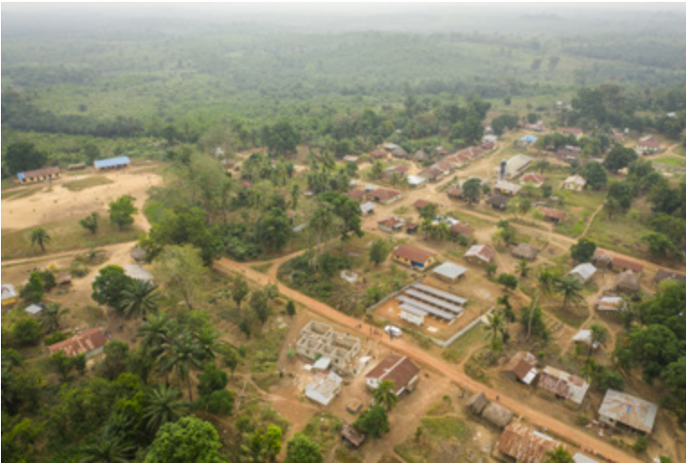
Asantys Energie-Container installiert als Dorfstromversorgung von PowerGen in einem Dorf in Sierra Leone. Foto: Michael Duff – InfraCo
