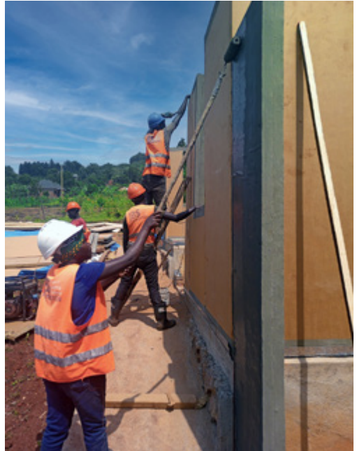
CO 2 -neutral hergestellte Strohpaneele bilden die Wände des neuen Frauenzentrums. Foto: IBS Foundation
