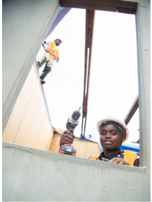
Ohne Akkuschauber geht nichts beim Zusammenfügen der Strohpaneele.
