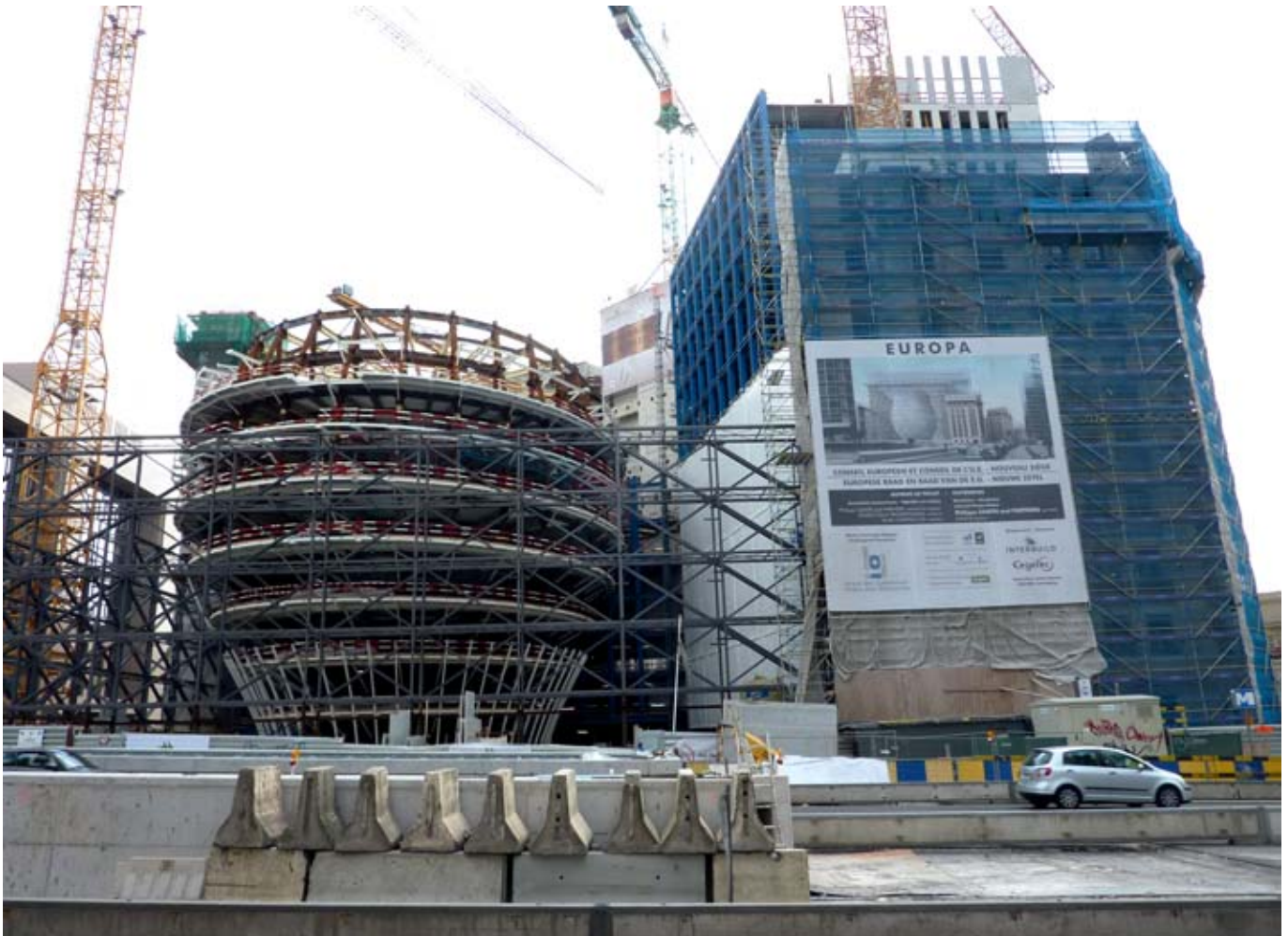
Nicht nur am neuen Gebäude des Europäischen Rats in Brüssel wird gebaut. Auch im Bereich Sozialpolitik sind die Regelungsambitionen der EU ungebrochen. Foto: Riki – Wikimedia
